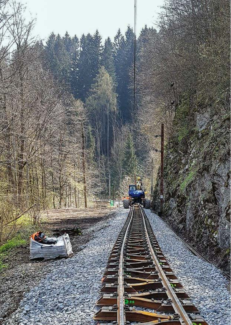
Ilustr. snímka č. 4: Oceľové podvaly tvaru Y, moderný a ekologický traťový zvršok na horskej trati
